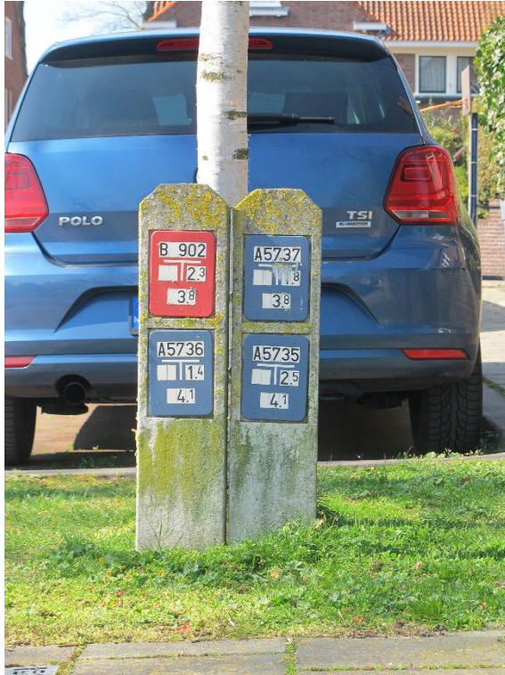
Aanwijzers voor een brandkraan en afsluiters in de Herman Gorterstraat
